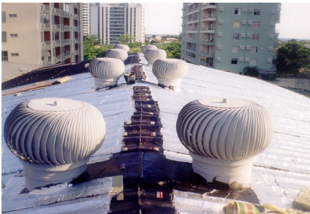
Foto 1 Instalação das mantas
