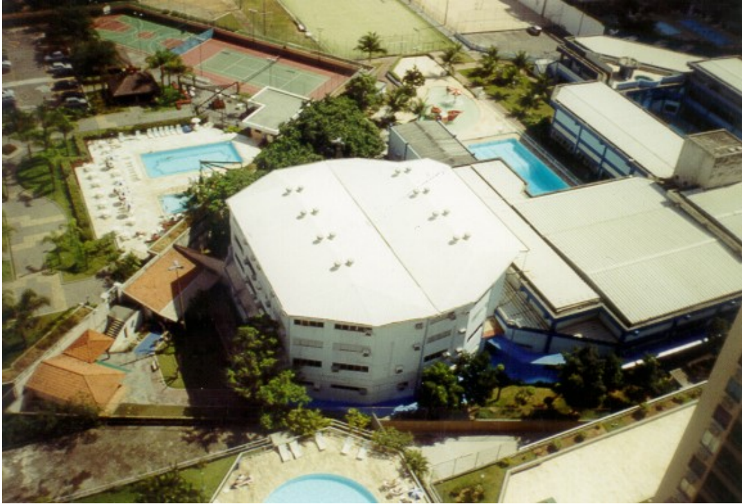
Foto 3 Vista aérea da obra entregue. Outubro 2002
