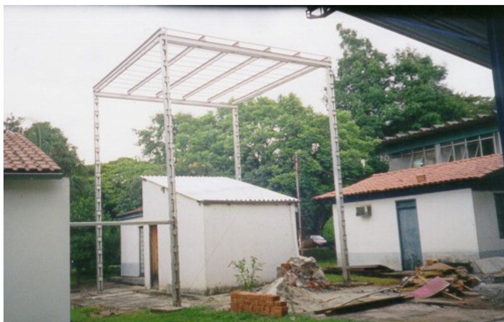
Foto 4 Vista geral do conjunto de telhas e estrutura para a realização do ensaio
